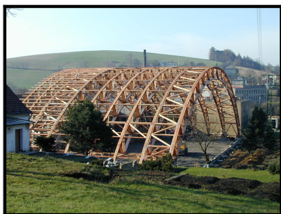
Acoperis din lemn sala de sport
