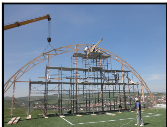
Acoperis din lemn teren de fotbal
