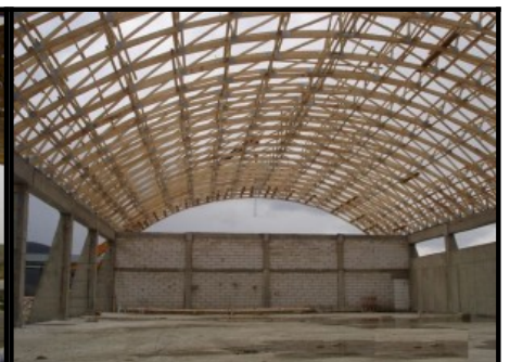
Hale din lemn si depozite din lemn cu ferme din lemn tip arc de cerc
