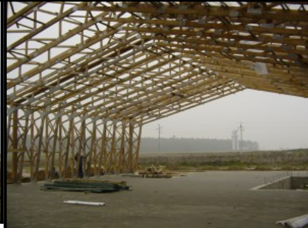
Hale din lemn cu ferme tip portal- cadre din grinzi cu zabrele din lemn
