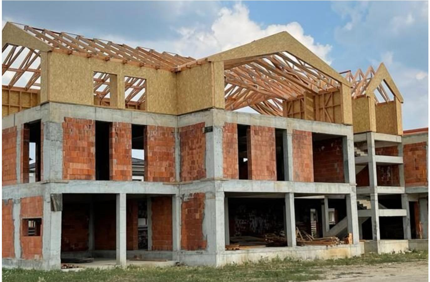
Vă prezentăm o mansardă open space (11 m dechidere fară reazeme intermediare) pe structură din lemn, montată în comuna TUNARI, Jud. Ilfov, peste placa din beton armat de la etajul 1 al unei clădiri rezidențiale.
